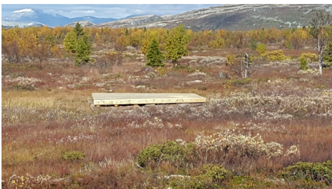
Kloppe 3 over Lundtjønnbekken ved nedre Lundtjønn. Masse er senere kjørt på for å sikre god oppkjøring på begge sider. Denne delen av traseen mellom Rondesenteret og Granhaugen, kan nå kjøres mye tidligere kommende sesong.
